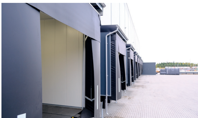
Bygget har yttervegger av sandwichelementer.
