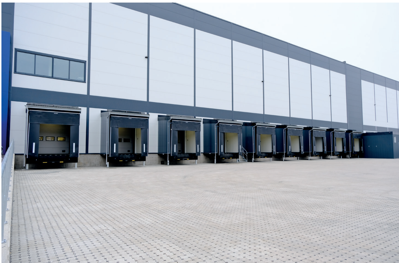
Bygget er oppført med bæresystem i stålfagverk.
