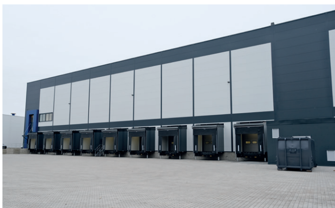
Fryselageret har strenge krav til lufttetthet.
